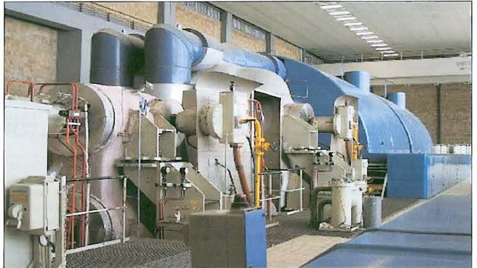
Abb. 1 Beispiel eines Dampfturbine-Generator-Strangs
